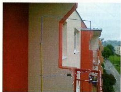
Obr. 4. Jednoduché provedení celovlnného čtverce z hliníkového drátu z VNA kabelu v praxi
